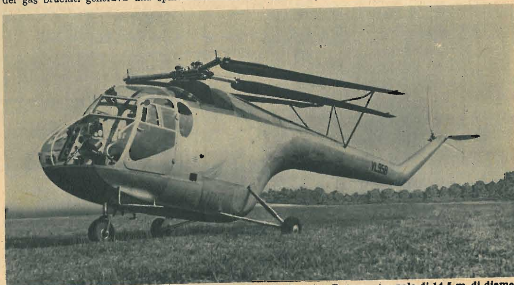
BRISTOL 171. Quadriposto inglese di tipo analogo al Sikorsky. Rotore a tre pale di 14,5 m di diametro; motore Alvis Leonides da 500 cav; peso complessivo 2360 kg; velocità massima 195 km orari.
